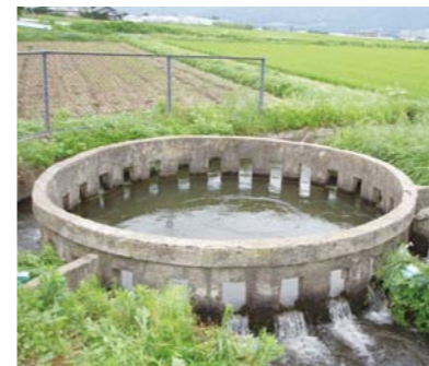
▲ 円筒分水工（伊那市）水を均等に分けて水田に流すはたらきをしています。
