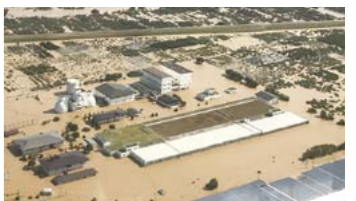
▲浸水したクリーンピア千曲 (長野市)
